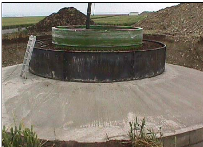
foto 4 - Stavba gravitačních základů 4
