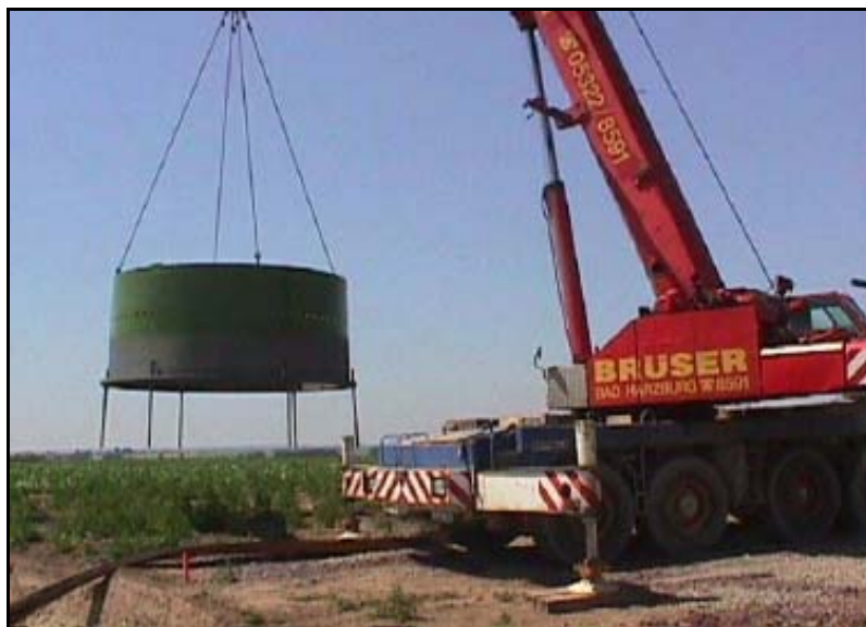
foto 1 - Stavba gravitačních základů 1
