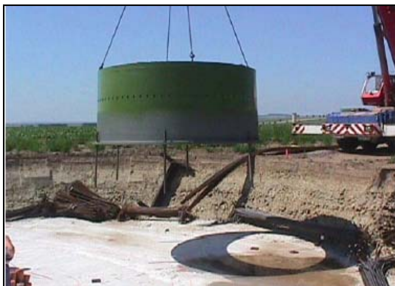
foto 2 - Stavba gravitačních základů 2
