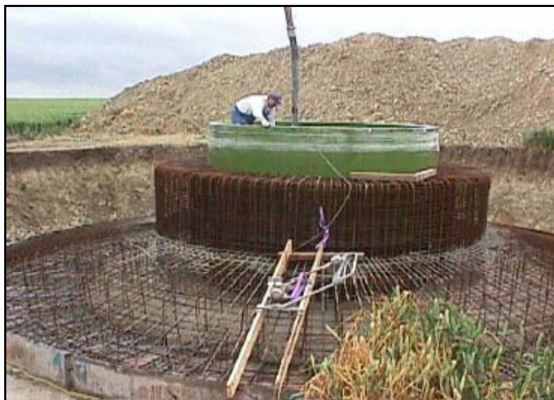
foto 3 - Stavba gravitačních základů 3
