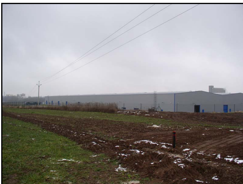
obrázek 3: Výrobní areál, sousedící na V s pozemky FTE
