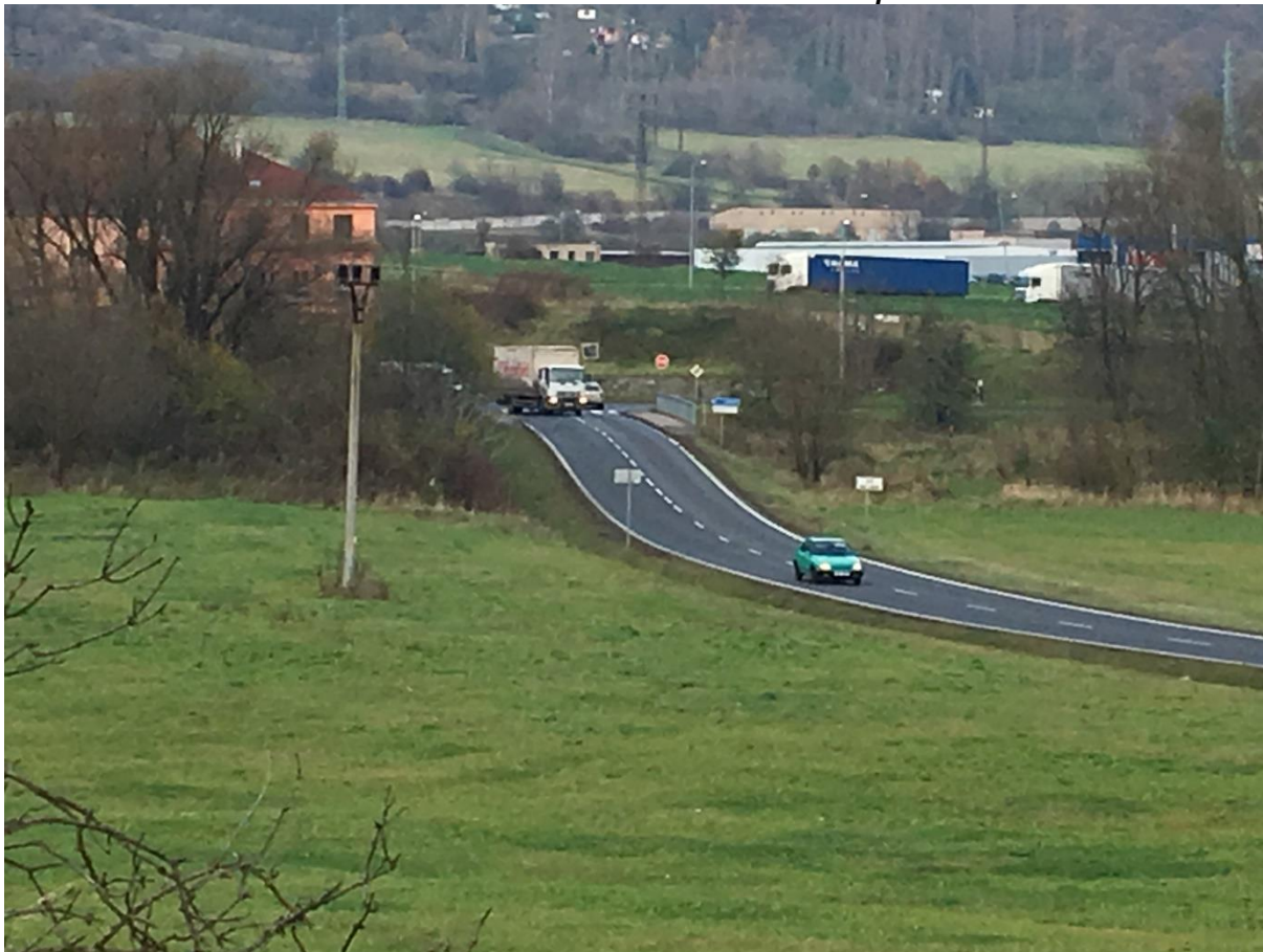
Obrázek č. 7 – Pátevní komunikace – ulice Jana Roháče – severní pohled
