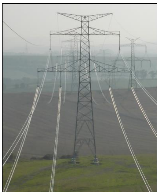
Obr. č.4: Nový nosný stožár tvaru DUNAJ
