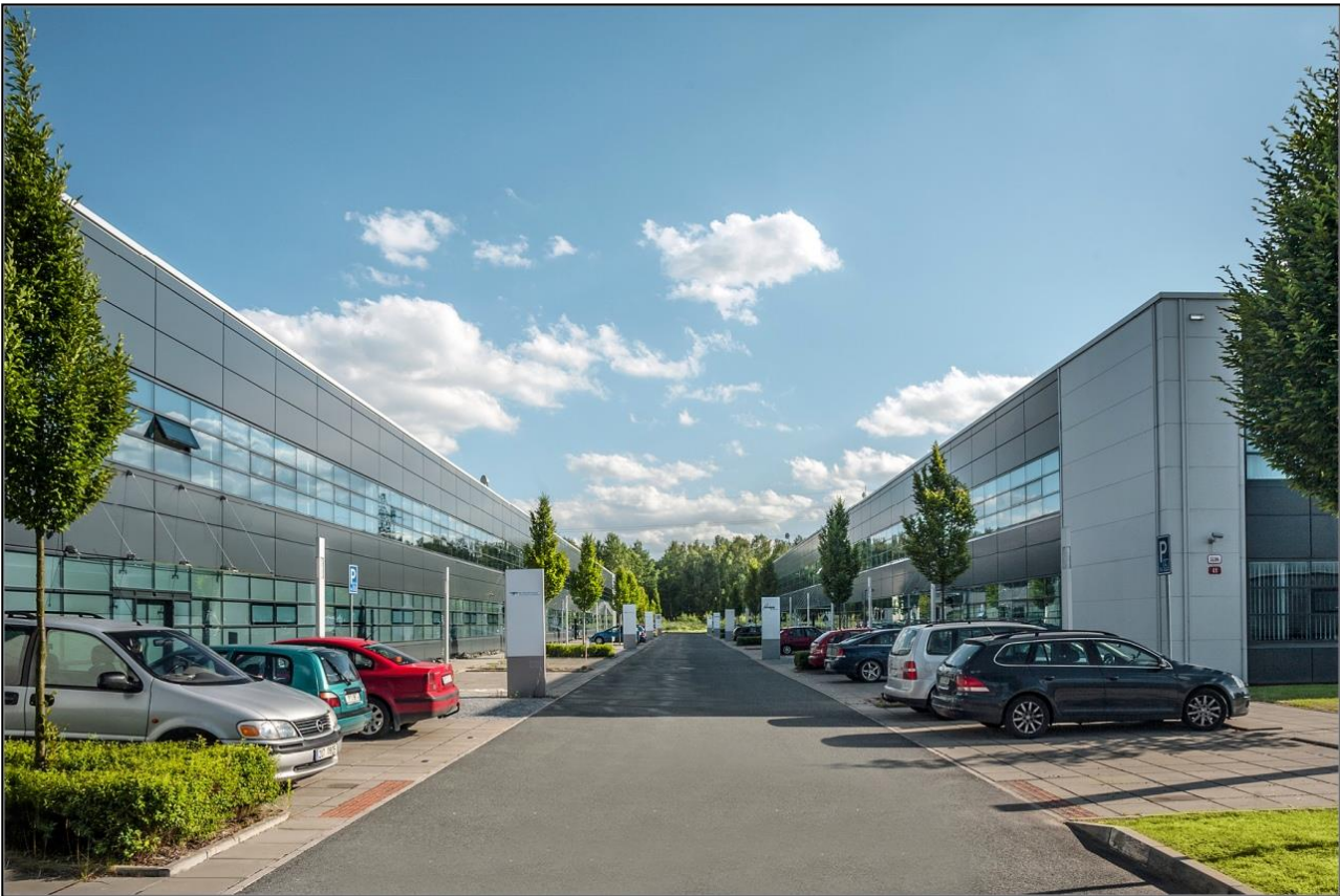
Obr. 2 Již realizované a provozované objekty stejné koncepce.
