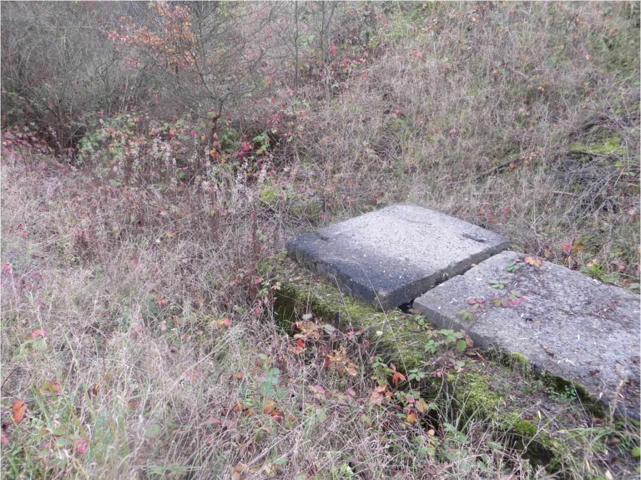
Obr. 21 Šachta zatrubněného bezejmenného vodního toku protékajícího podél severní hranice řešeného území
