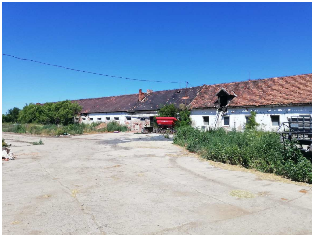
Pohled na stáj určenou k demolici
