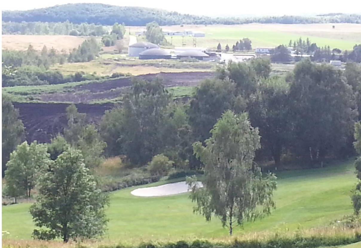
Celkový pohled na bioplynovou stanici přes rekultivaci Juros s.r.o.
