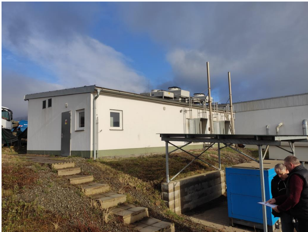
Stávající objekt kogenerace
