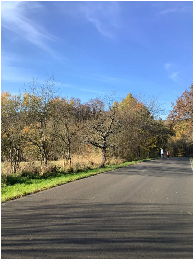
Obrázek 40 Pohled na stávající silnici III/26224, lokalita navrženého mostního objektu přes přeložku I/13 (km 7,450)
