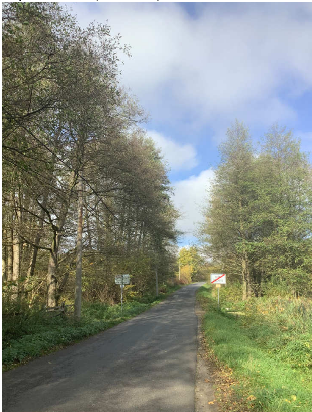
Obrázek 52 Pohled na stávající silnici III/26211 v Horní Libchavě, v místě navrženého křížení mostním objektem na přeložce I/13 (km 20,500)
