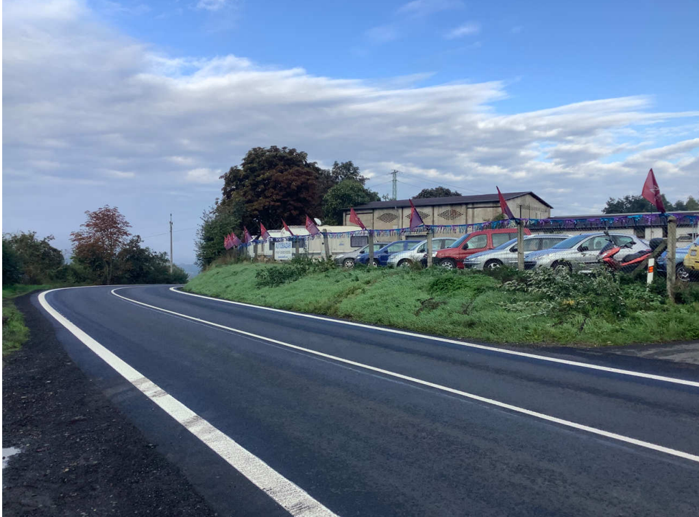
Obrázek 32 Pohled na stávající silnici II/262 v části Děčín – Březiny, začátek stavby (km 1,825)
