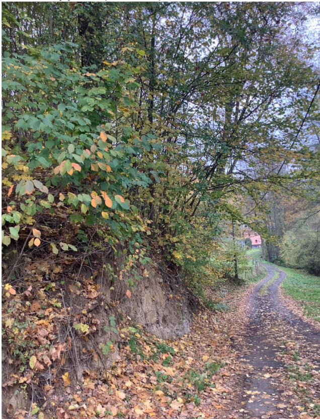
Obrázek 34 Pohled na místní komunikaci v k. ú. Březiny u Děčína, severně od navrženého mostu přes cestu a Dobrnský potok (km 2,500)
