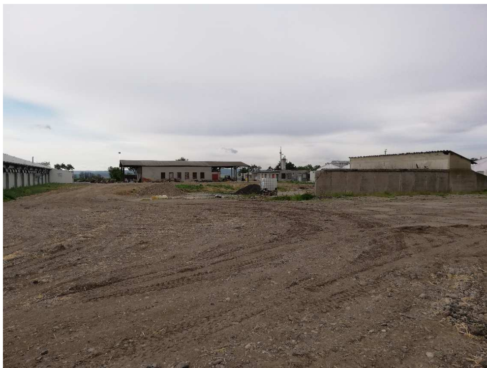
Pohled na místo stavby vpravo zbytek žlabu určeného k demolici
