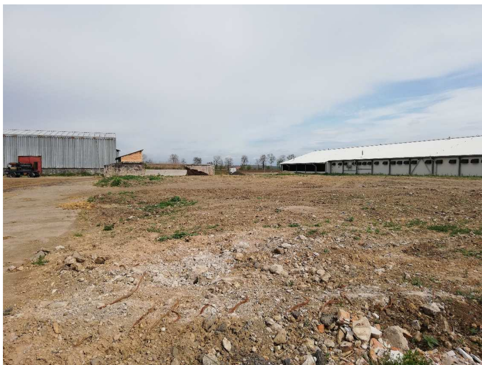
Pohled na místo stavby od jihu
