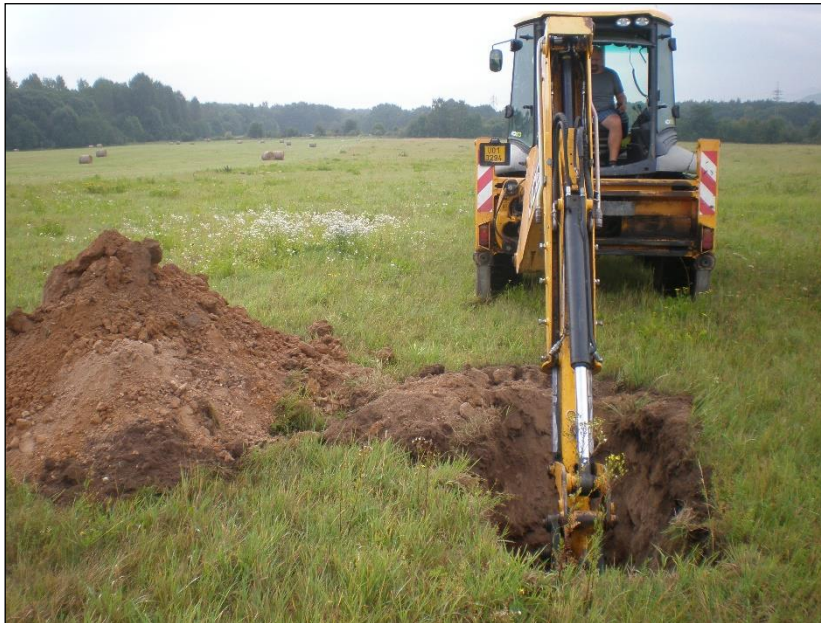
Posuzovaná lokalita, výkop průzkumné sondy č. 5
