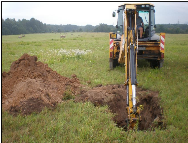
Kopání sondy č. 5 a horninový materiál ze sondy
