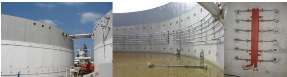
Obrázek 10: Vytápění fermentoru
