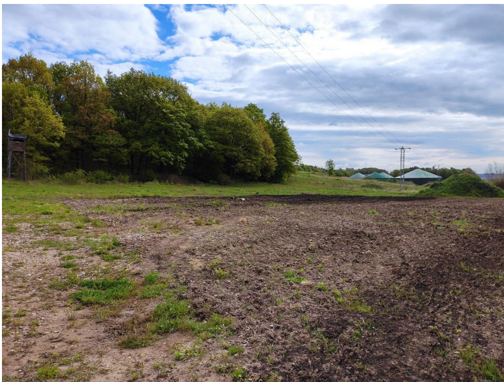
Pohled na křížení budoucího plynovodu s LBC
