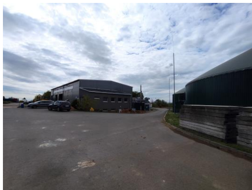
stávající příjmová hala
