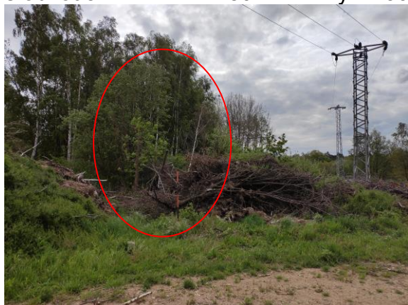
Obrázek 20: Prostor odstranění dřevin v trase napojení podzemního plynovodu
