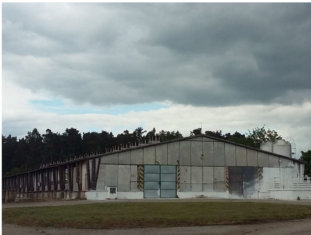
Pohled do areálu na halu 8 určenou k modernizaci
