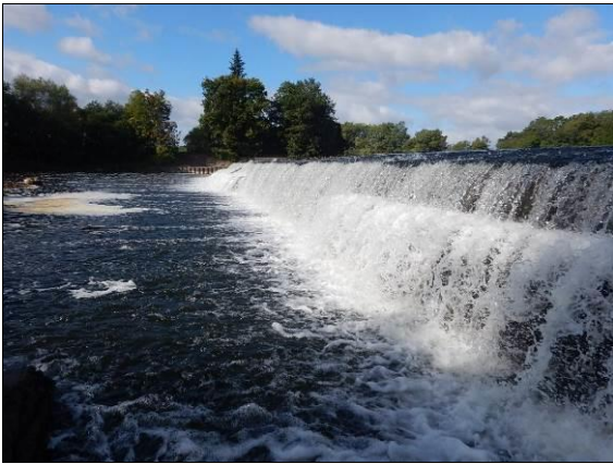
Pohled na stávající jez v Křesíně a jeho vývařiště.
