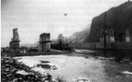
Obr. č. 16, 17: Stavba střekovského jezu a zdymadel
