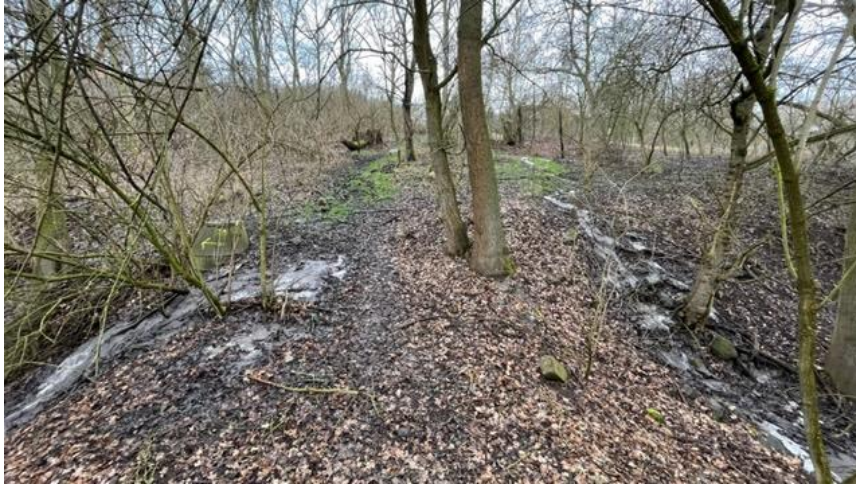
Obrázky č. 19-20 Přítoky z pravostranného prameniště nad Dobětickým potokem nad stávající hrází s propustkem
