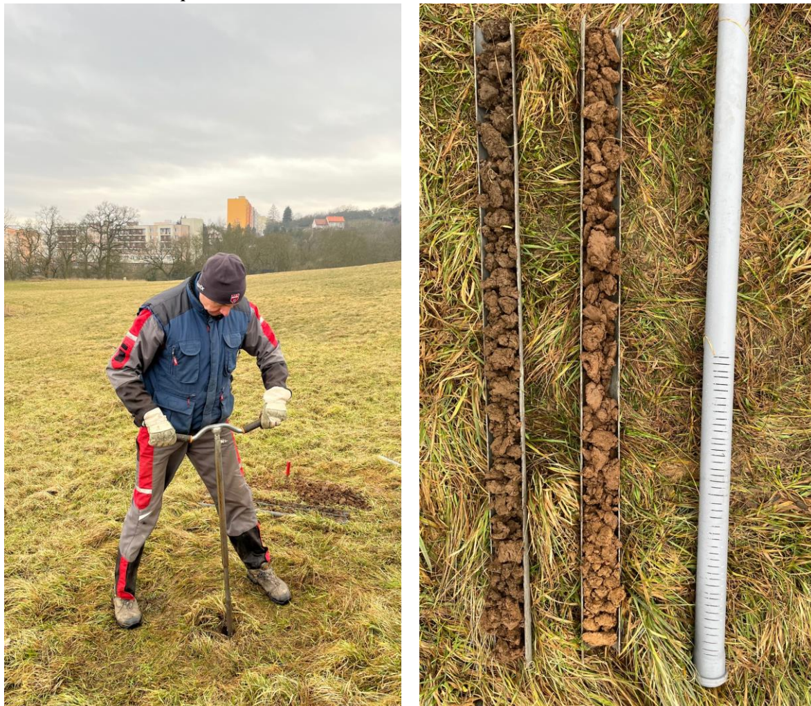
Obrázek č. 28 Vrtné práce na vsakovací sondě J-1
