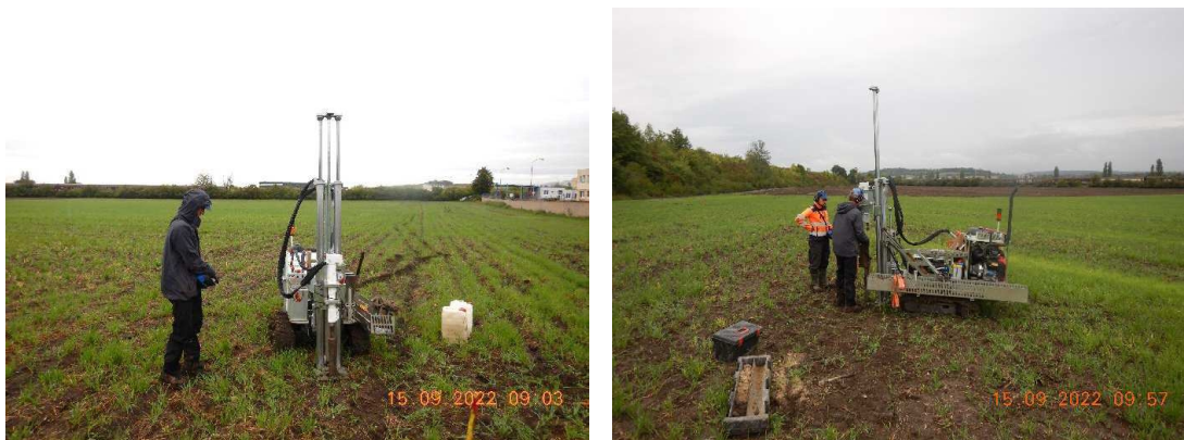
Obr. 7,8: Pohled k severu na hloubení sondy S7 soupravou Argos-HH, pohled k západu na hloubení S8.
