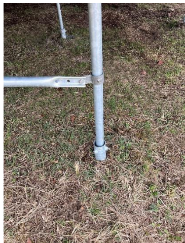
Zapuštěná konstrukce do zemního vrtu
