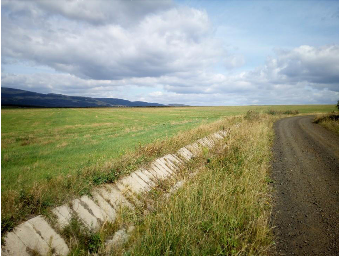
Obr. 10. Pozemky stavby jsou ohraničeny cestou a odvodňovacím kanálem
