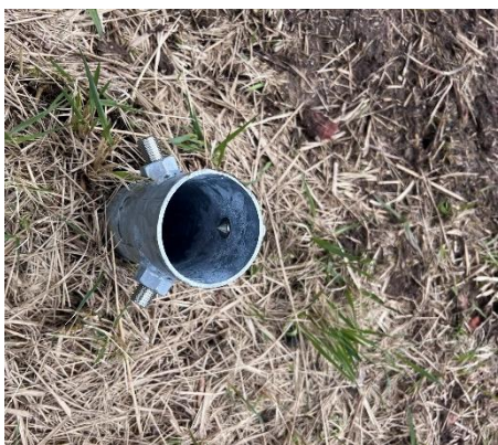
Zemní vrt pro zapuštění konstrukce
