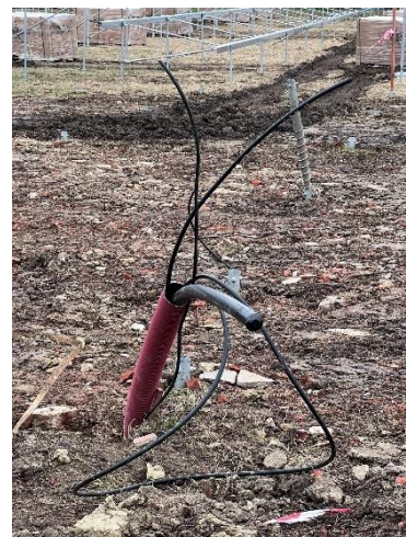
Vyvedení kabelů k připojení do řad solárních panelů
