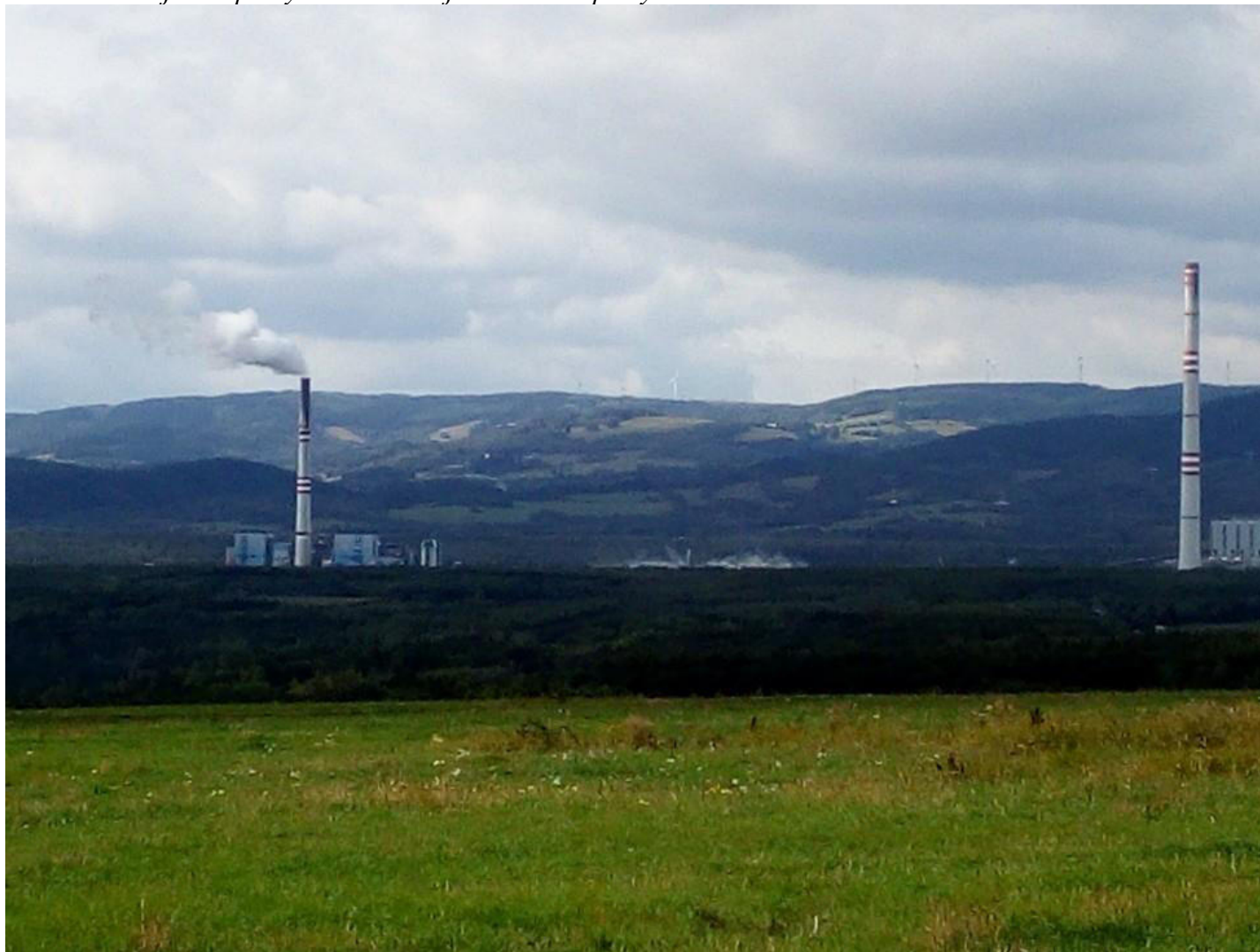
Obr. 15. Určujícími prvky KR v ObKR jsou tělesa tepelných elektráren
