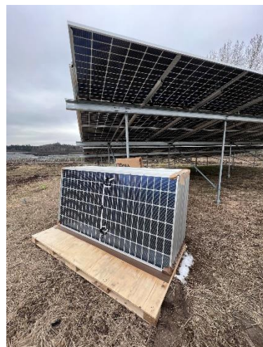
Postupná instalace konstrukcí a upevňování panelů
