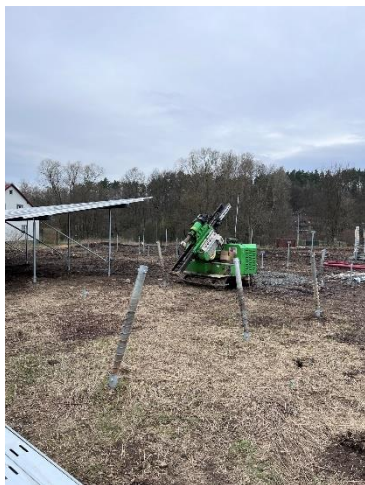
Zařízení k vrtání pro zapuštění konstrukcí
