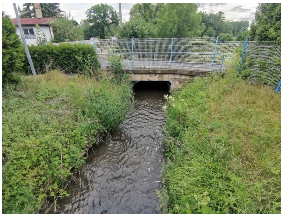
Obr. 8 Dílčí plocha 6 – technicky upravené koryto Ždírnického potoka v objektu
