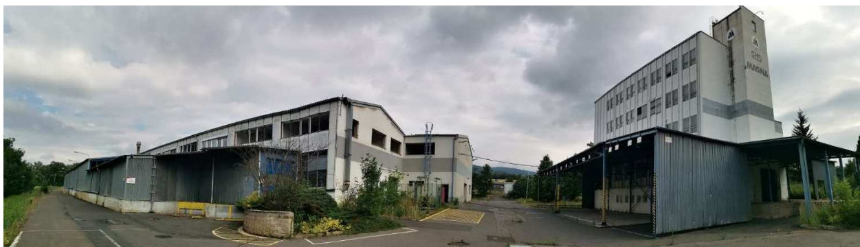
Obr.1 Dílčí plocha1 – pohled na bývalý areál Chabařovických strojřen
