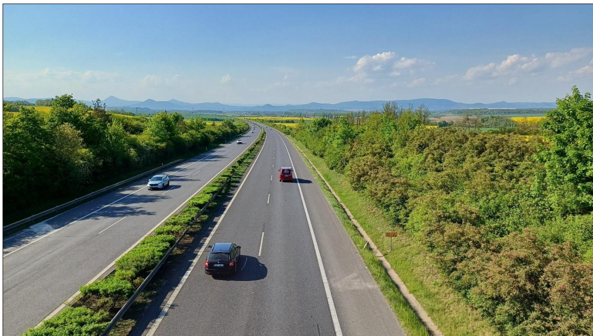
Obr. 9: Dálniční těleso při pohledu z mostu II/246, v pozadí panorama Českého středohoří
