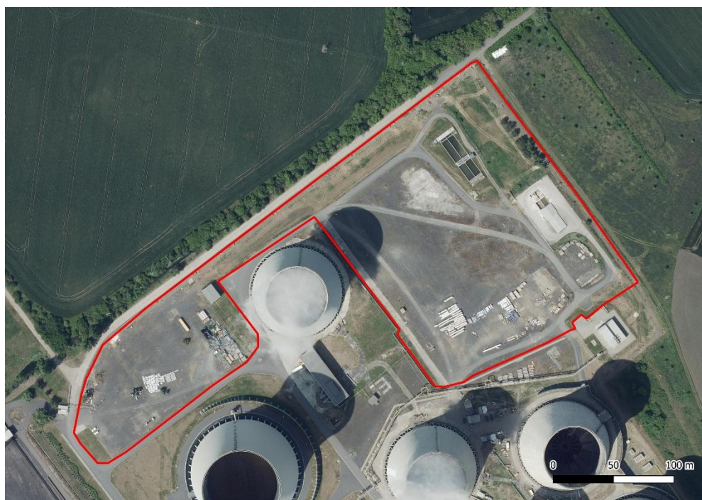
Obrázek 1: Sledovaný úsek průzkumu v areálu paroplynové elektrárny Počerady
