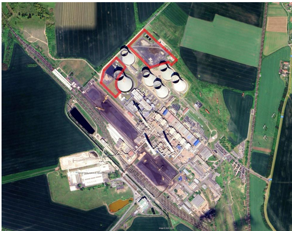
Obrázek č. 1: Pohled na areál elektrárny v Počeradech s vyznačením polohy PPC 2 a PPC 3; zdroj: Google Earth
