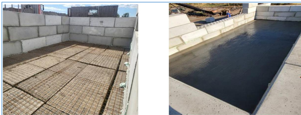
Obrázek č. 8: Schéma provedení reakční vany pro úpravu odpadů (stabilizaci/solidifikaci)
