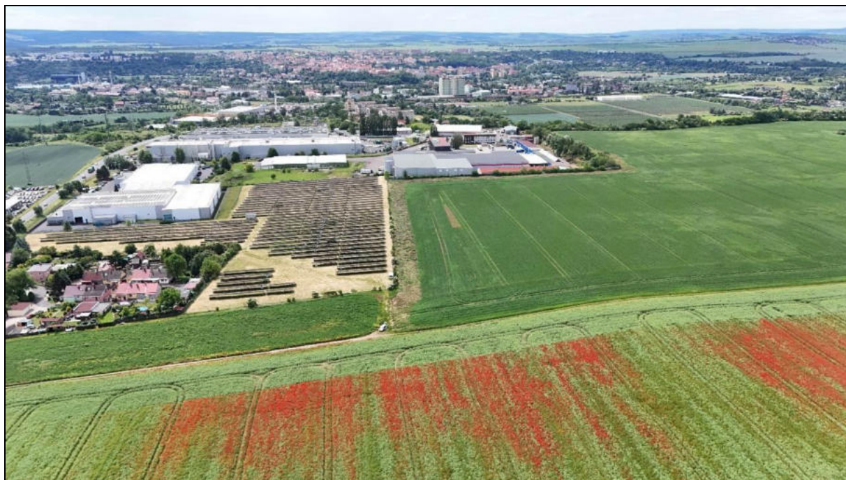
Obrázek 21: Na ploše posuzovaného záměru se v současnosti nachází zemědělsky obhospodařované plochy. V pozadí lze vidět intravilán Žatce s moderní i historickou zástavbou
