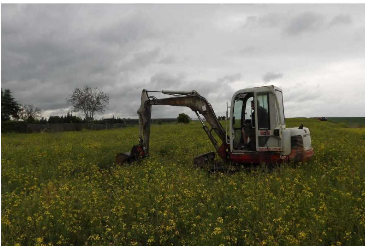
Strojové kopání sond.
