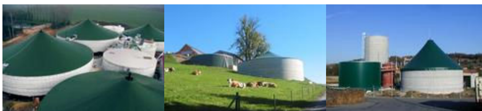
Obrázek 3: Fermentory s integrovanými plynojemy (zdroj:Wolf system)
