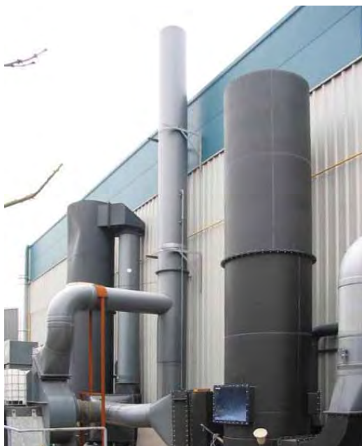
obrázek 16 – Ilustrační foto – skrubr na referenční jednotce
