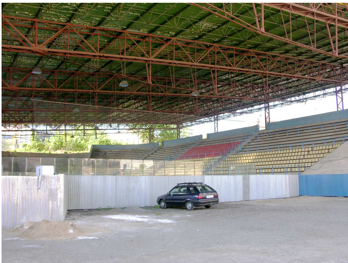
Pohled na halu od Zahradnické ulice
