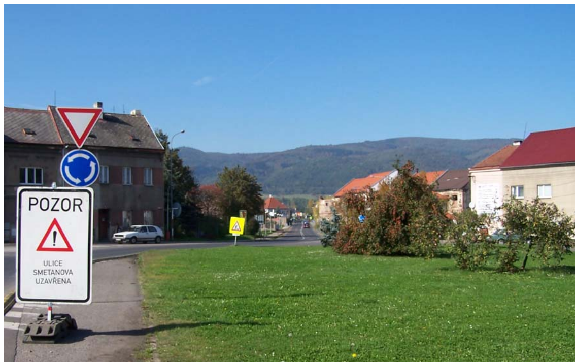
Obr. 2 Stávající stav pohled do ul. Teplická (silnice II/253 směrem na Přestanov)
