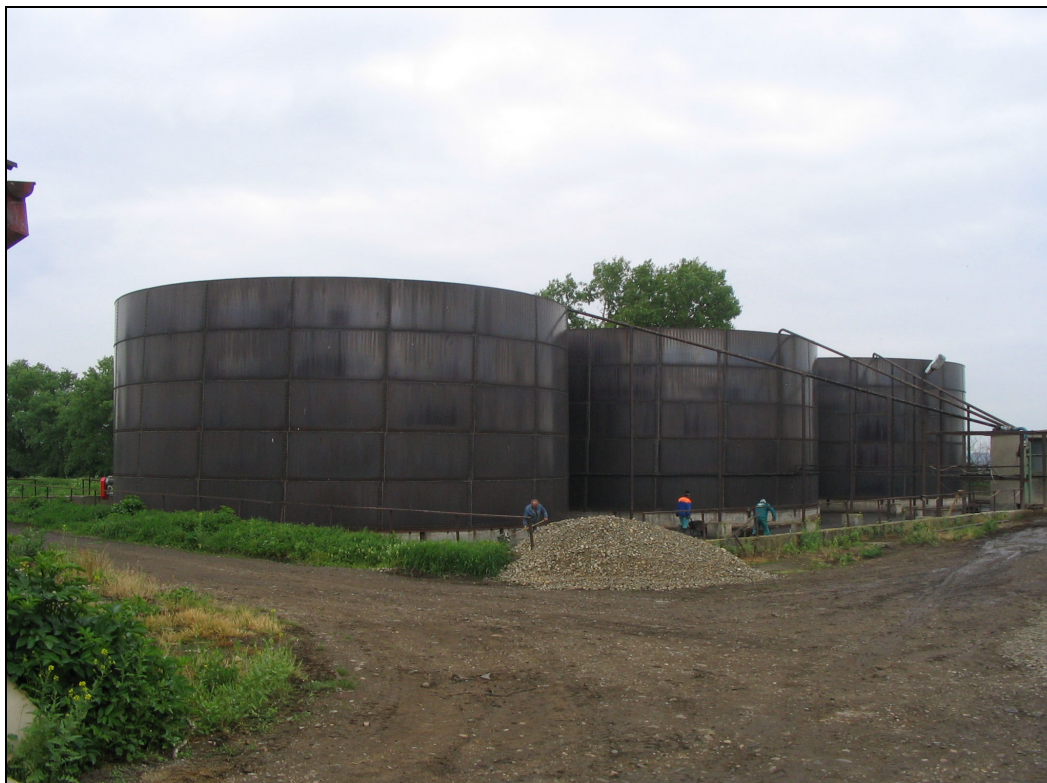
Obrázek 4. Stávající kejdové hospodářství – otevřené nadzemní jímky
