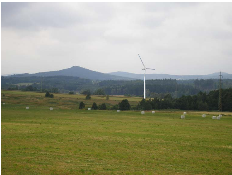
Obr. 1: Pohled na elektrárnu od východu.
