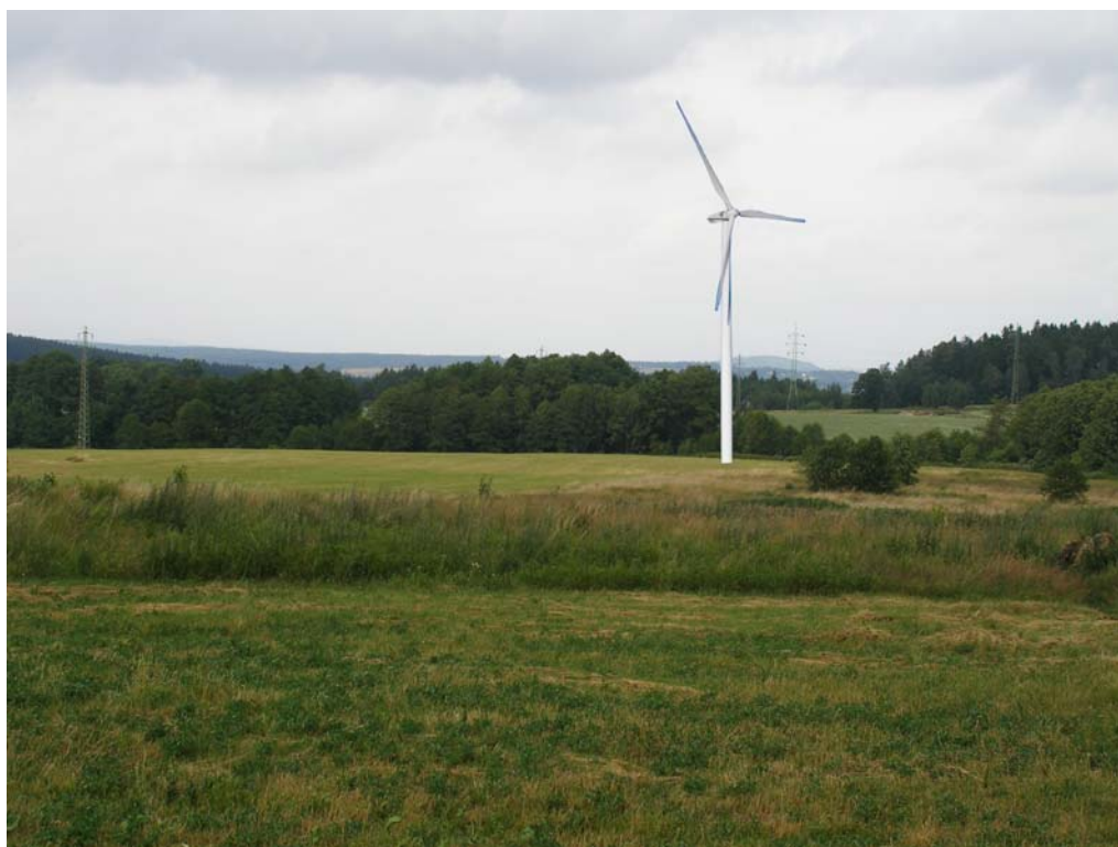
Obr. 2: Pohled na elektrárnu od jihu.
