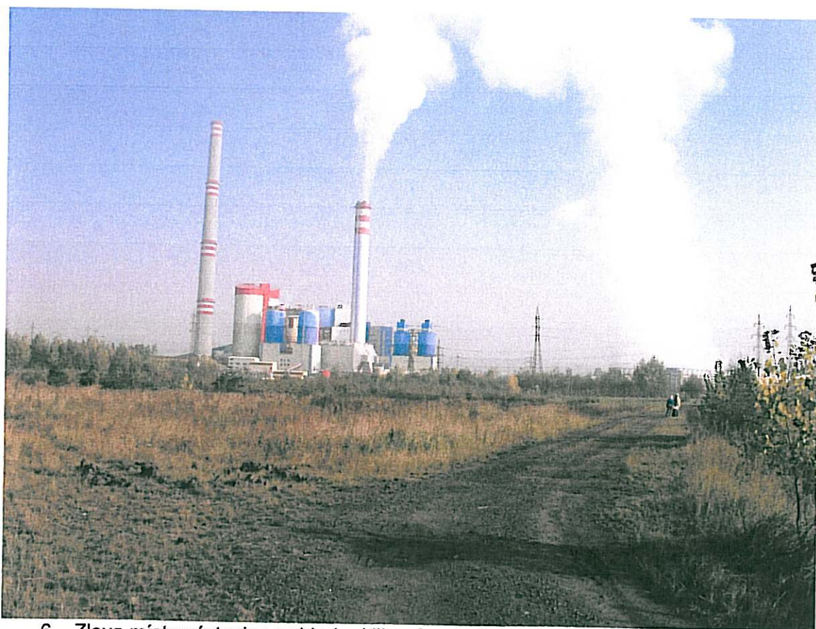
6. Zleva místo výstavby, pohled od jihozápadu 1
