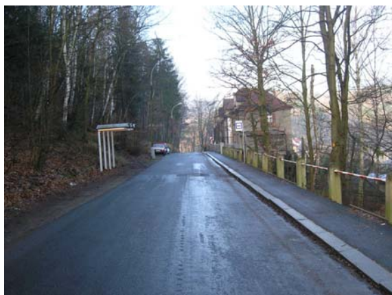
Obr. 1 Příjezd k havarovanému úseku z části Škrabky
