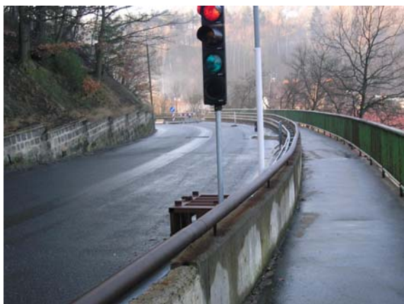
Obr. 3 Náhled do úseku s omezenou dopravou
