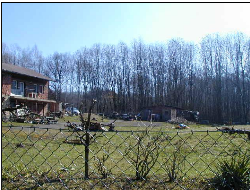
Obrázek 19: Pohled na objekt s č.p. 39 z cesty k zahrádkářské kolonii.
