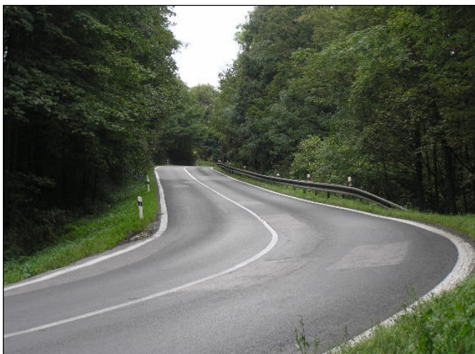
Obr. č. 14 Okolí silnice I/9 – úsek č. 2
