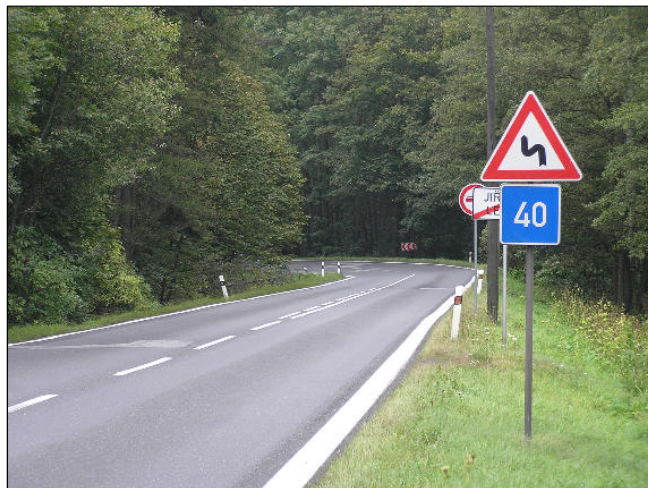
Obr. č. 3 Úsek č. 2 ve směru na Rumburk
