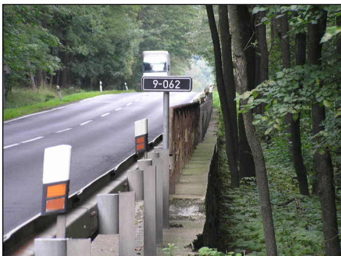
Obr. č. 4 Stávající klenbový most č. 9 – 062 na úseku č. 1
