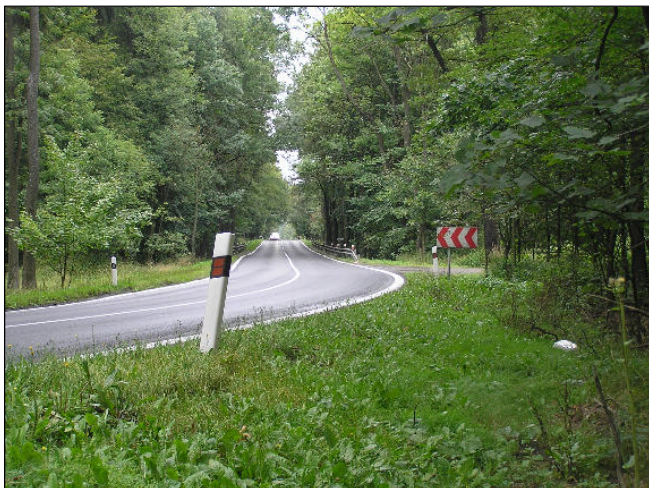
Obr. č. 2 Úsek č. 1 ve směru na Rumburk
