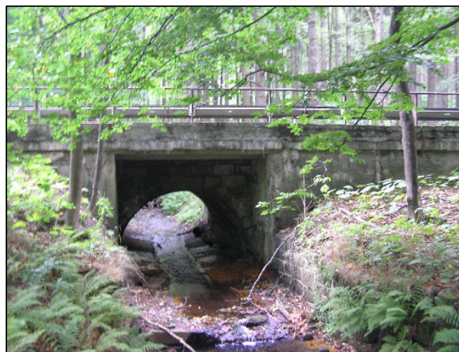
Obr. č. 5 Boční pohled na stávající klenbový most
