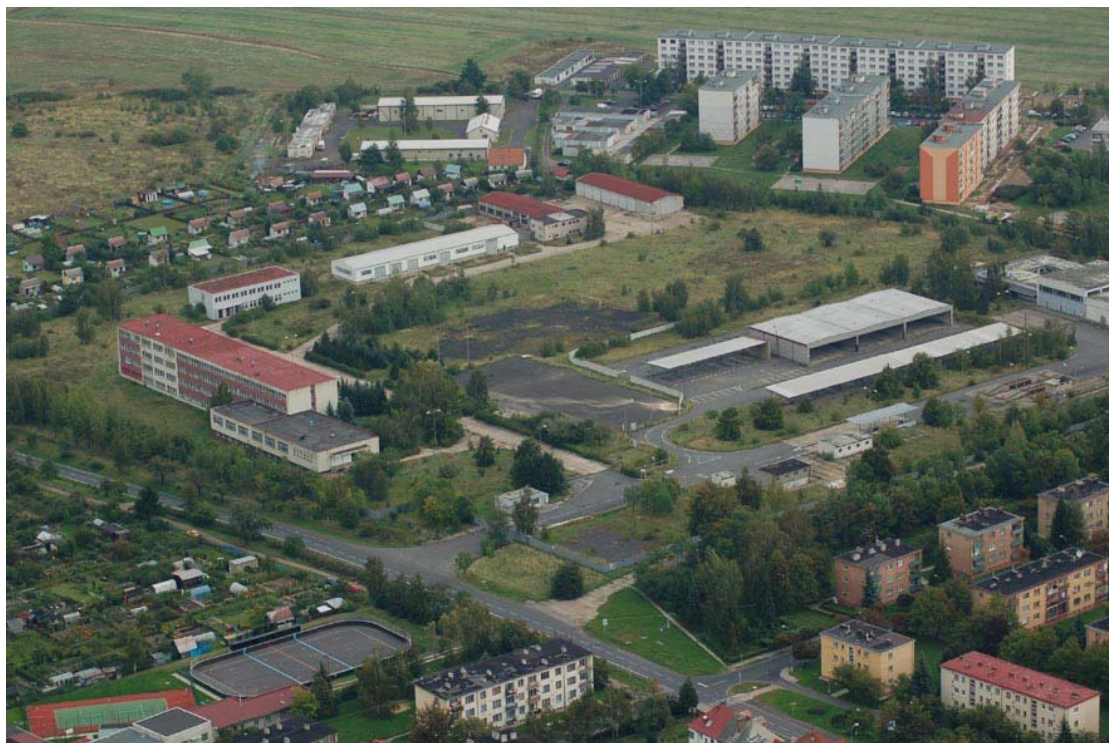
Obr. 3 Pohled na zájmovou plochu před demolicemi objektů. Zájmová plocha letního stadionu je v horním rohu plochy kasáren
