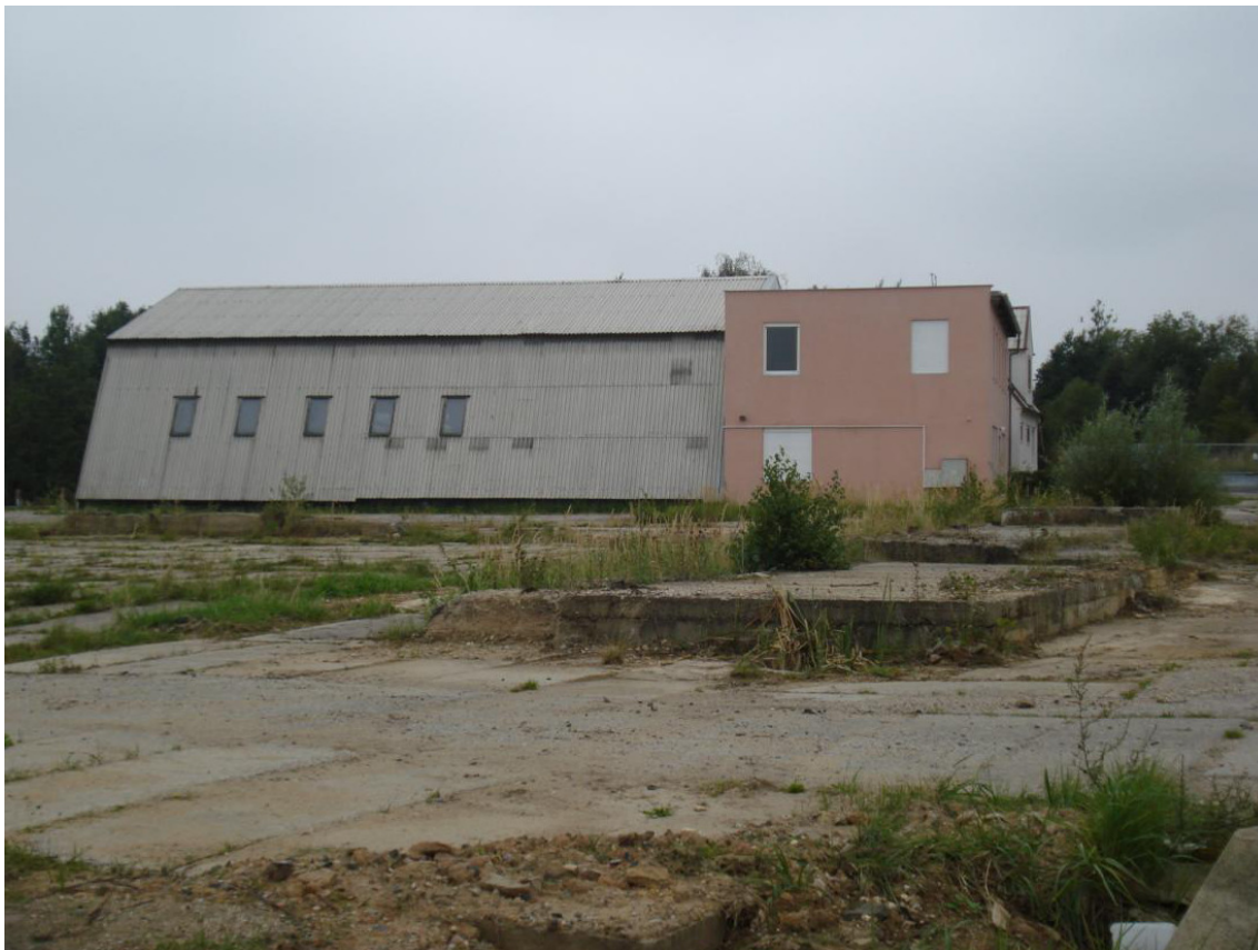
Obrázek č. 2 Stávající prodejní sklad (objekty č. 2, 3)
