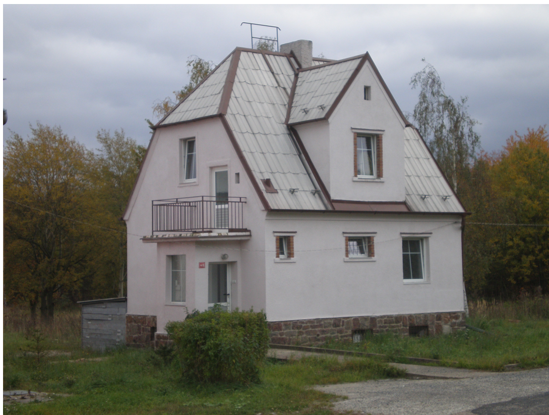
Obrázek č. 1 Bývalý rodinný dům (objekt č.1)
