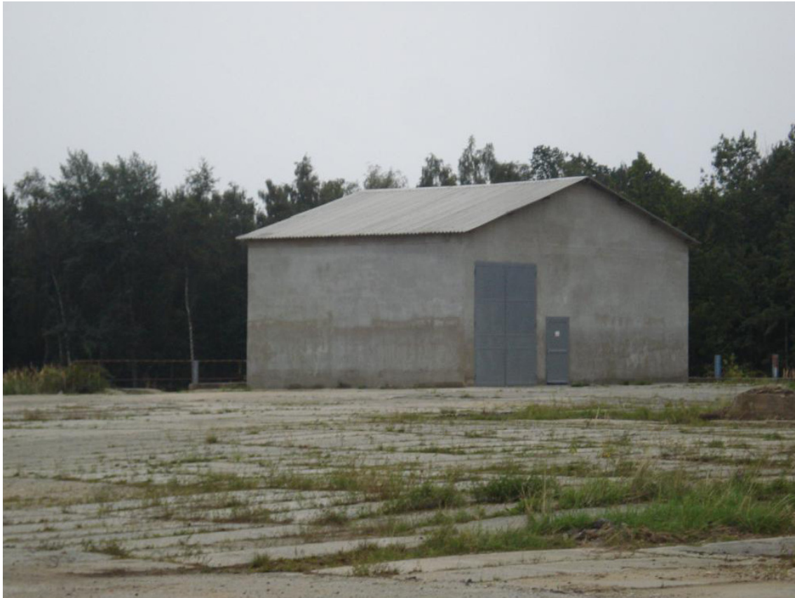
Obrázek č. 3 Stávající sklad (objekt č. 4)
