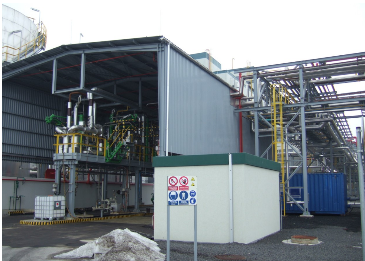
Obrázek 10 : Stáčecí / plnicí místo autocisteren a systém potrubního propojení s nádržemi
