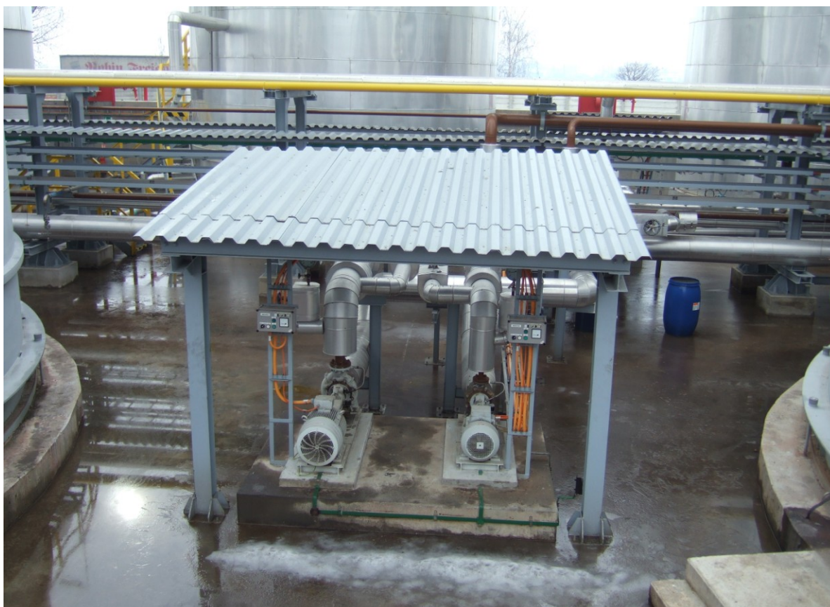
Obrázek 8 : Stávající čerpadla umístěná v objektu 6069
