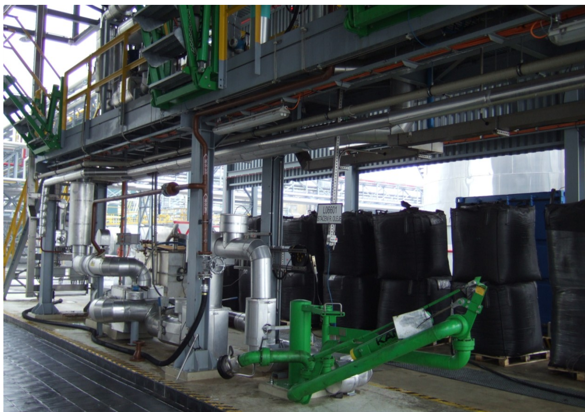
Obrázek 11 : Stáčecí / plnicí místo autocisteren, detail
