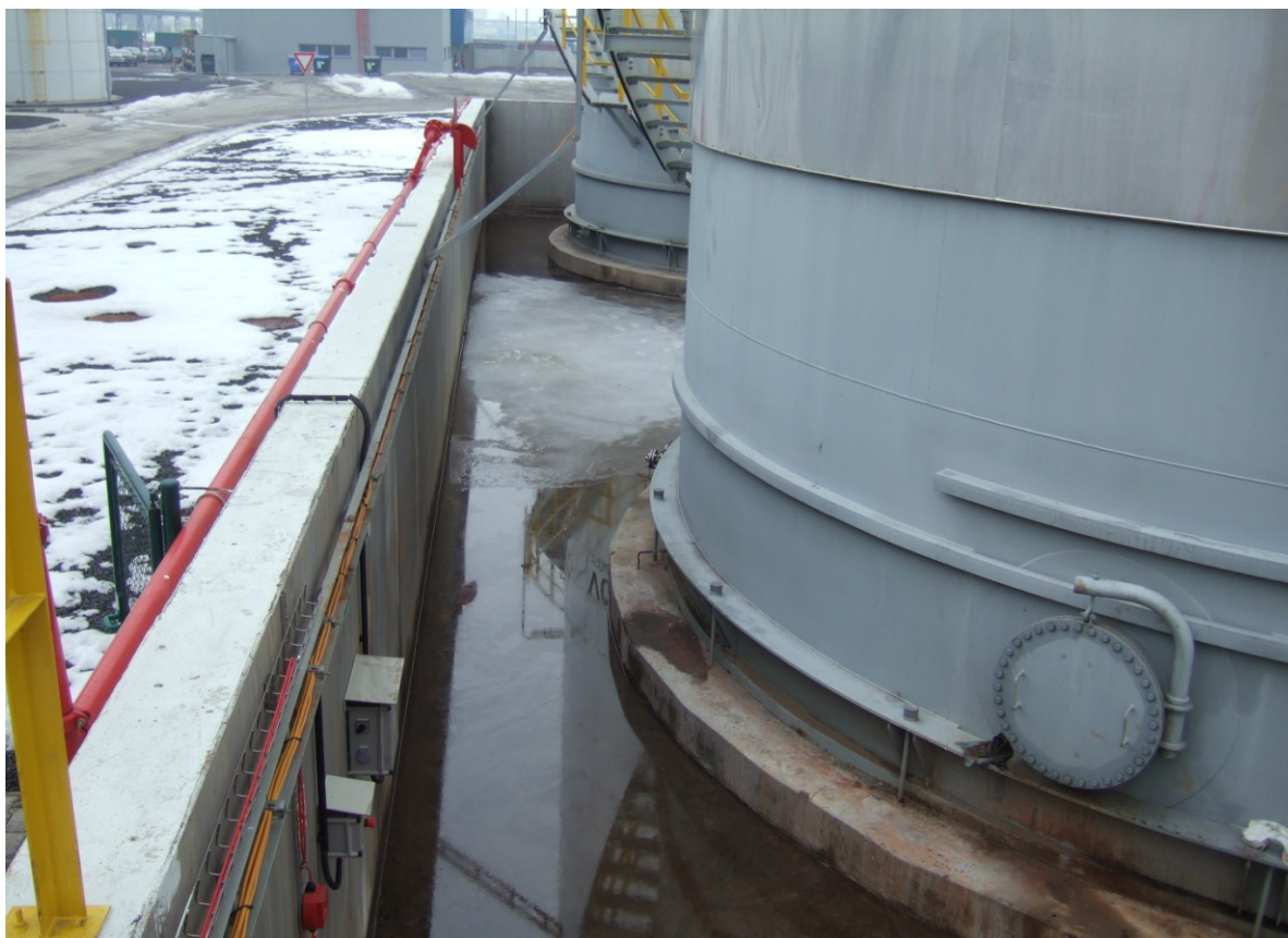
Obrázek 9 : Detail jímky a spodní části stávajících nádrží v objektu 6069
