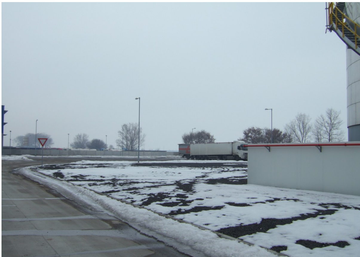
Obrázek 5 : Prostor pro stavbu z pohledu od nádrží
