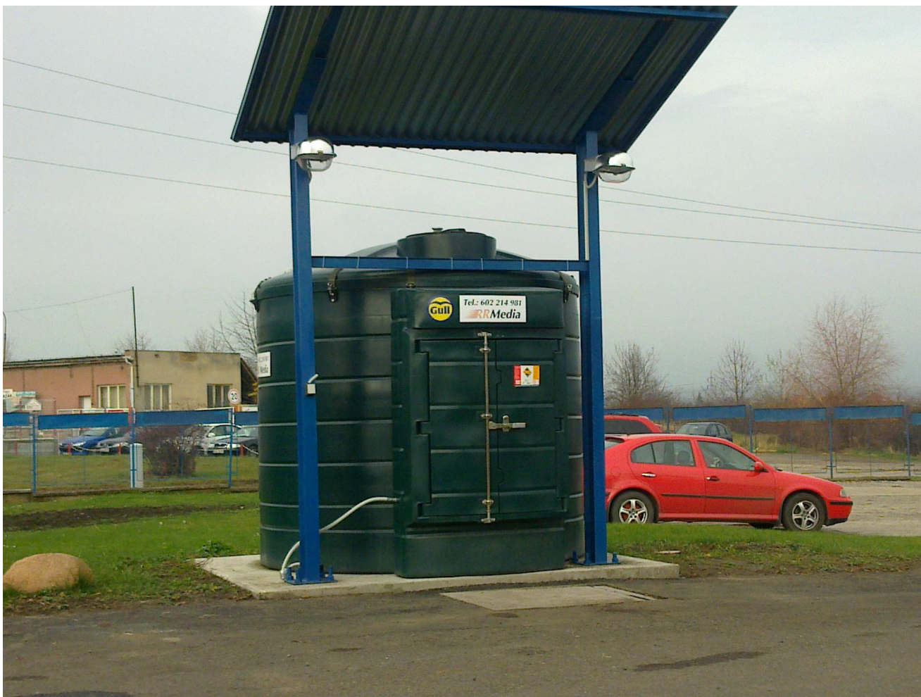
Obr. č.4: Nádrž VBFS 6000 – instalace v Teplicích
