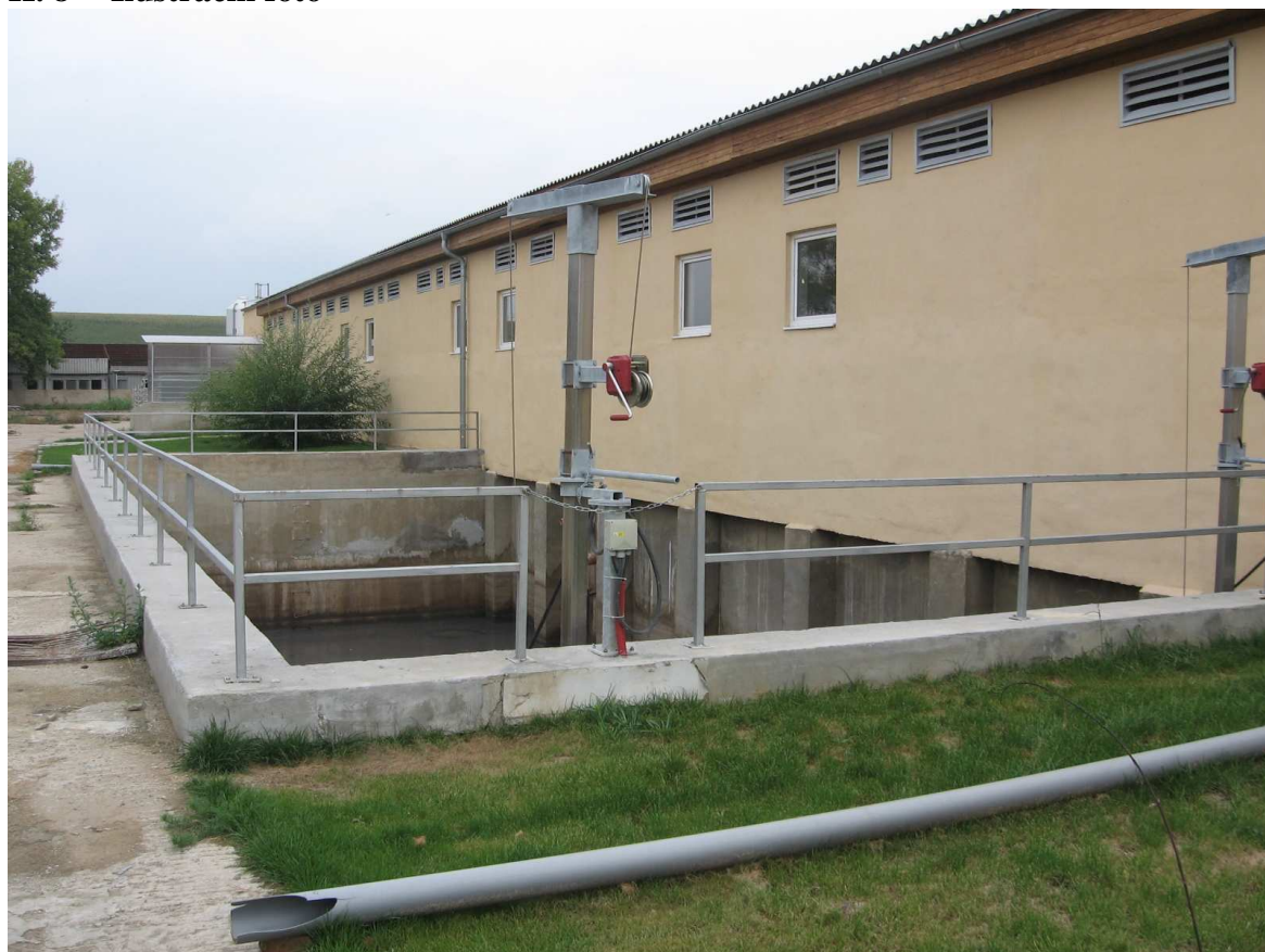
Pohled na stáj výkrmu po rekonstrukci v pozadí původní porodna
