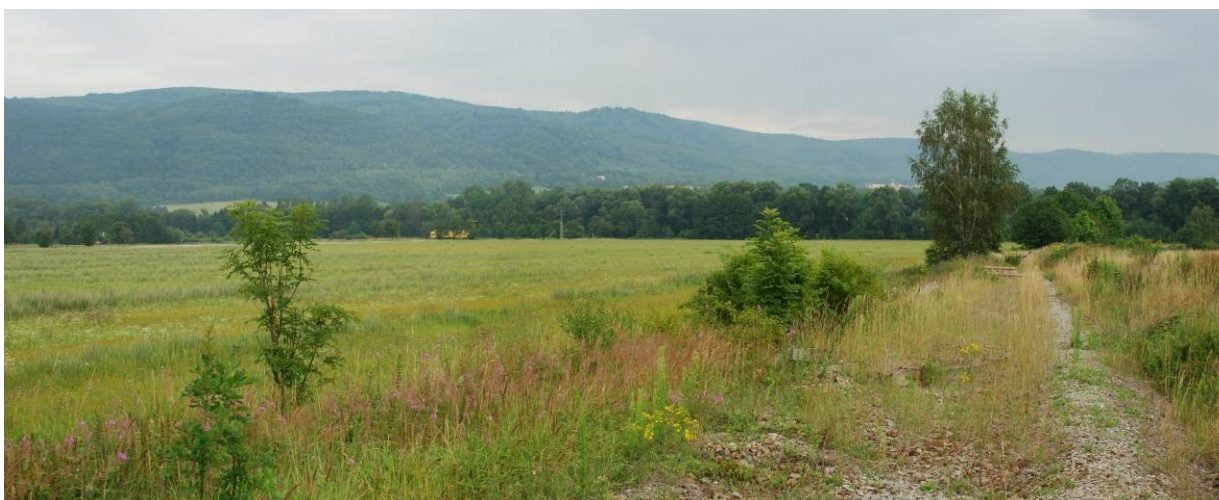
Obr. 4.1.3: Těleso bývalé vlečky tvoří jihovýchodní ohraničení západního segmentu navrhovaného areálu. V krajině dominuje mohutný pás doprovodné zeleně Habartického potoka a hradba zelených svahů okraje Nakléřovské hornatiny. (foto ATELIER V)
