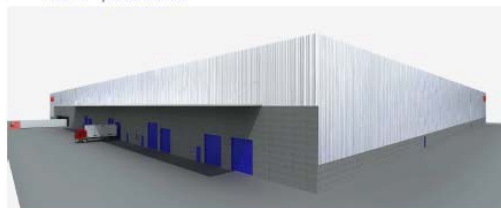
Hala "D" - pohled severní
