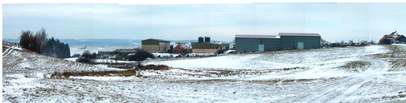
Pohled na středisko ZD Kouty od severu – v popředí zleva silážní žlab, sklad, dílny a posklizňová linka
