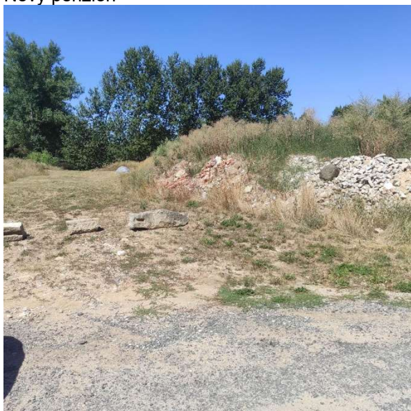
Uložená stavební suť
