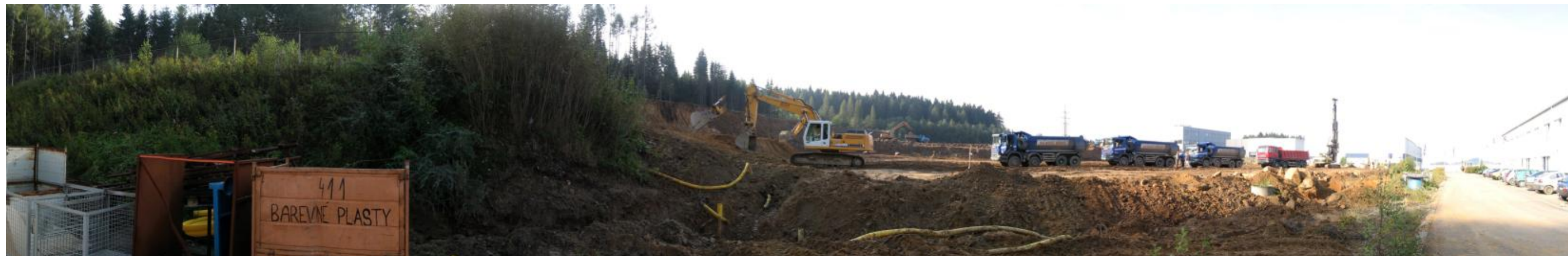
PANORAMATICKÝ POHLED OD SEVERU NA PROSTOR VÝSTAVBY HALY H2
