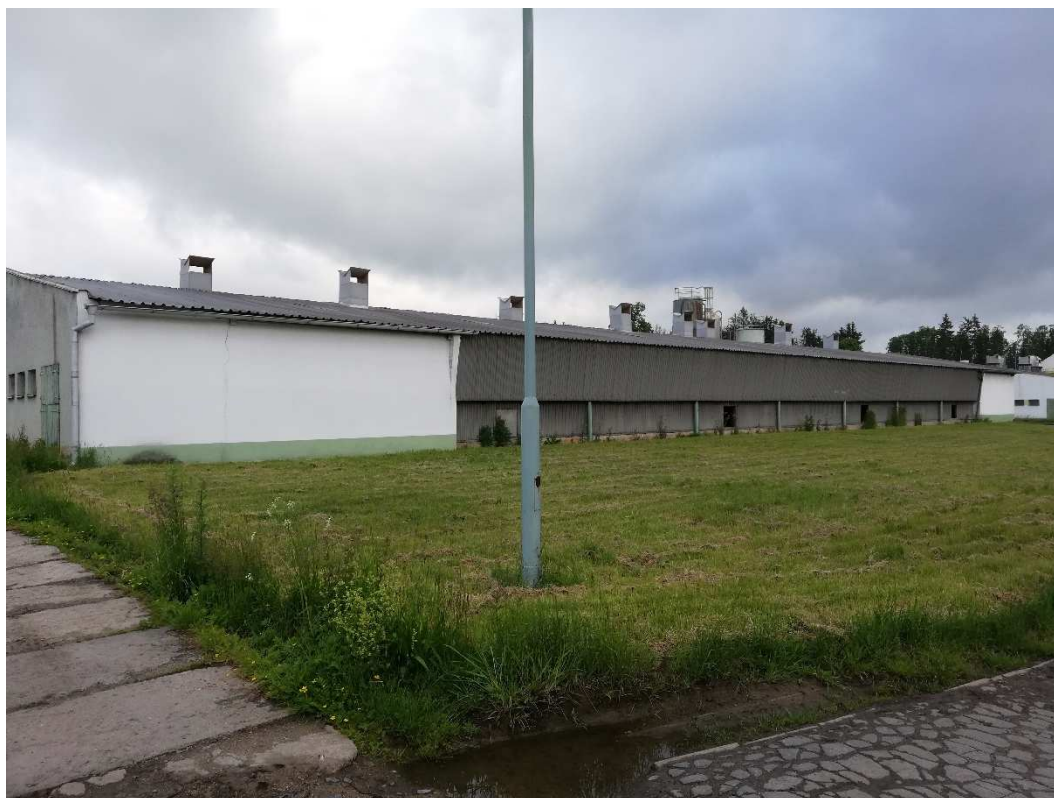
Pohled do areálu na stáj určenou k demolici
