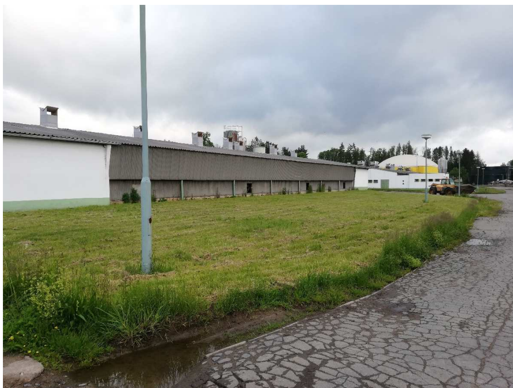
Plocha pro výstavbu - stáje určené k demolici (vlevo)
