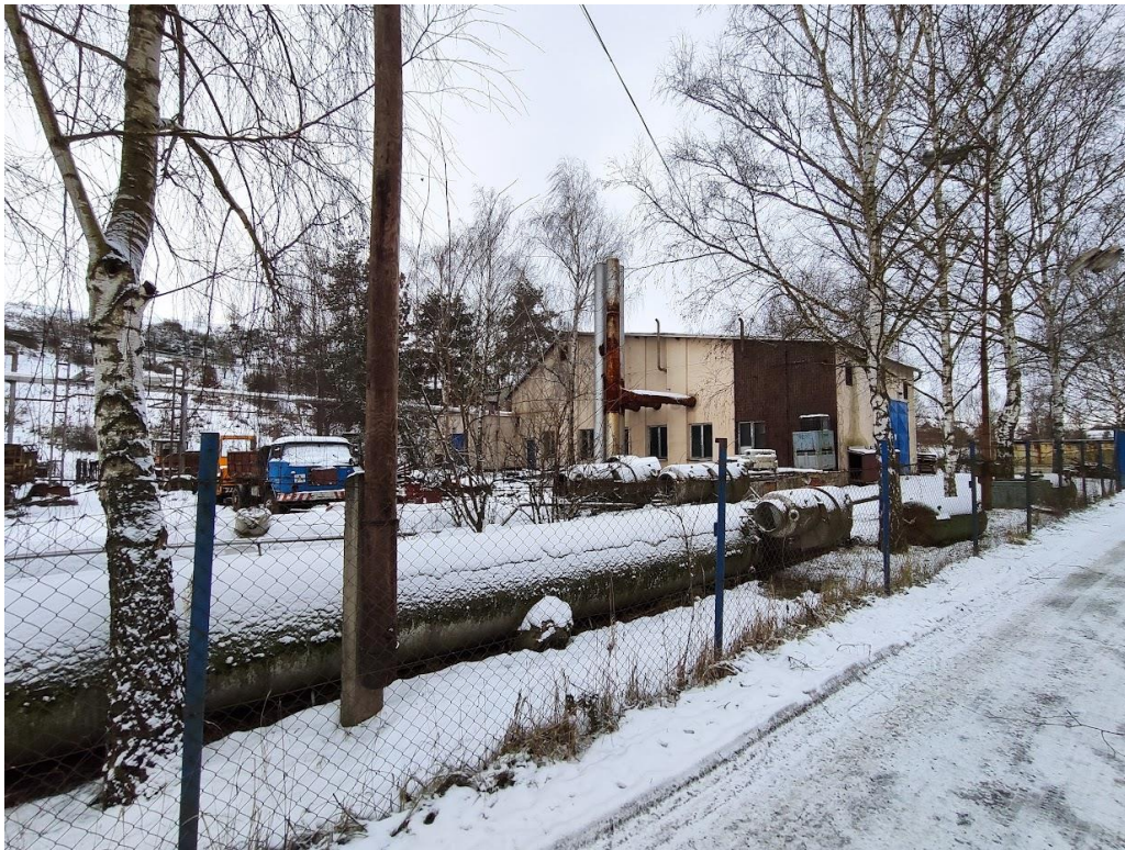
Prostor záměru s bývalou kotelnou
