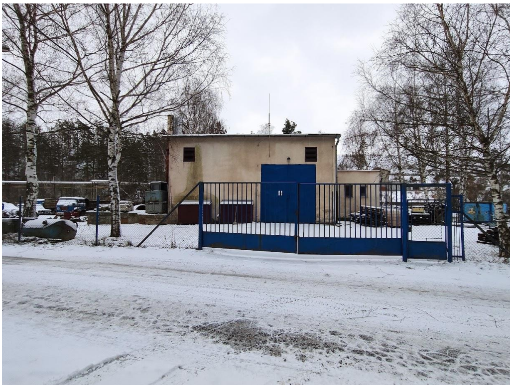
Vjezd do bývalé kotelny
