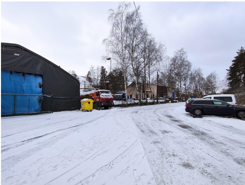
Pohled na prostor stavby směrem od vrátnice Tanex
