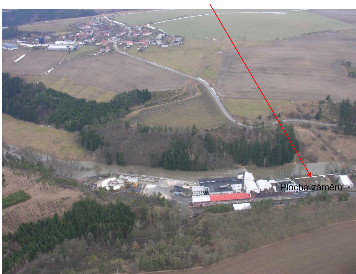
Obrázek 17: Rozsah povodně v roce 2005, zdroj: TANEX
