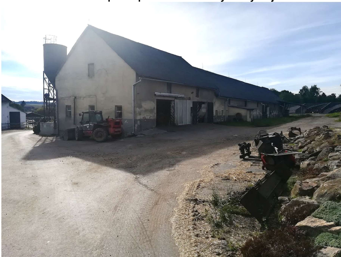
Severozápadní pohled na místo výstavby stáje
