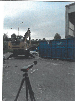
Pohled na nakládání kontejneru manipulátorem a v pozadí nakladačem
