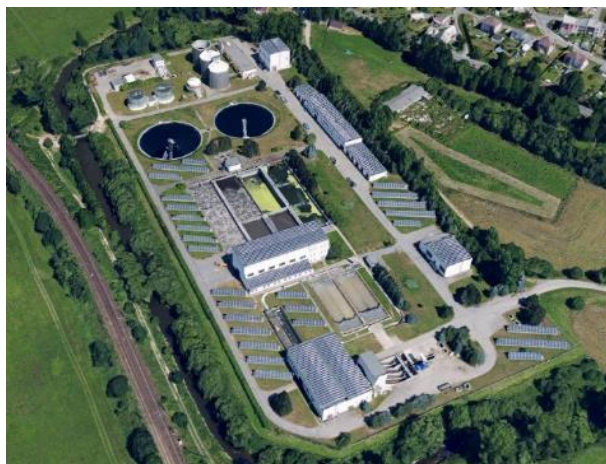
Obrázek č. 27 – Umístění solárních panelů na ČOV Havlíčkův Brod
