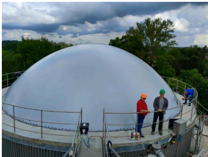
Obrázek č. 3 – Foto z tlakové revizní zkoušky zakrytí uskladňovací nádrže
