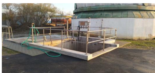
Obrázek č. 10 – Stávající příjmové místo a navrhované zastřešení ocelovou halou a s dezodorizačním biofiltrem
