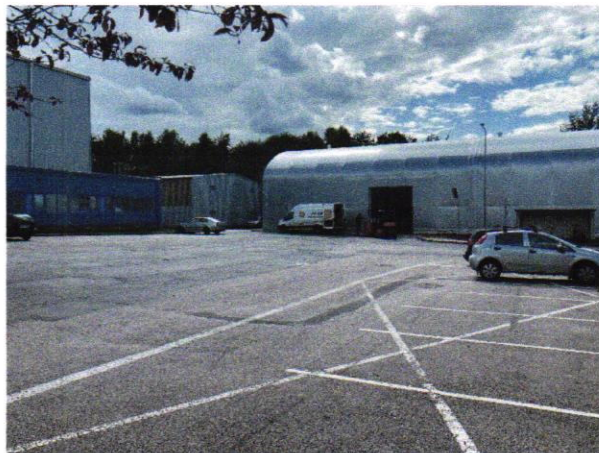
Obr. 6 Areál SCE – exteriér
