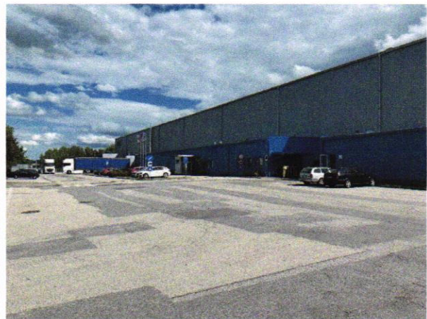
Obr. 7 Areál SCE – exteriér
