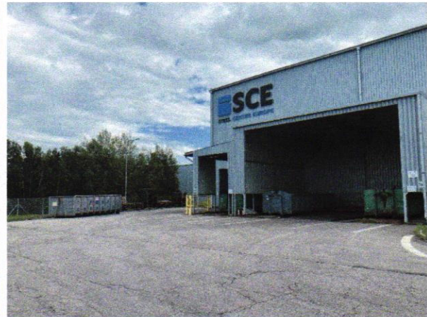
Obr. 5 Areál SCE – exteriér
