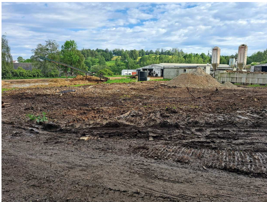
Pohled na prostor určený pro stavbu jímky
