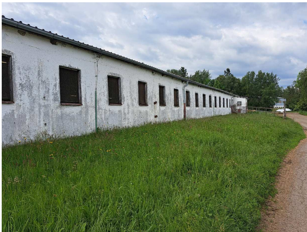
Pohled na stáj určenou k demolici
