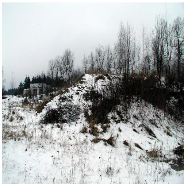
Deponie zemin na pozemku, určeném k výstavbě nových výrobních hal
